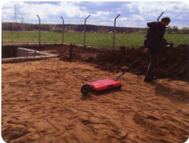
Рис. 2. Проведение георадиолокационных исследований распространения инъекционных растворов в песках
