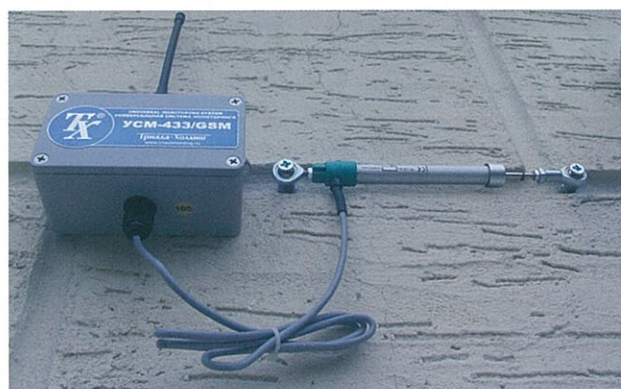
Рис. 3. Установленный на конструкциях здания измерительный модуль, оснащенный потенциометрическим датчиком деформаций
