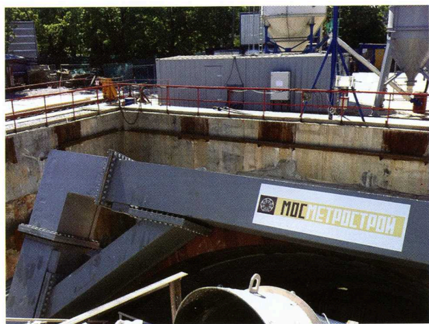
Рис. 1. Контейнер с оборудованием и силоса для приготовления двухкомпонентного тампонажного раствора непосредственно на стройплощадке
